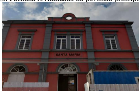
Figura 13: Fachada revitalizada do pavilhão principal da Gare
