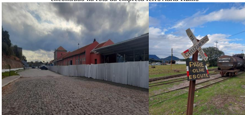
Figura 7: Pavilhões da Gare da Estação Ferroviária com tapumes devido às obras e trem de carga e cruzamento encontrado na rota da empresa ferroviária Rumo
