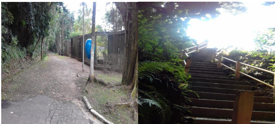
Imagem 2: PNM Cotia-Pará difícil acesso e falta de corrimão. Fonte: Valter Pereira.
