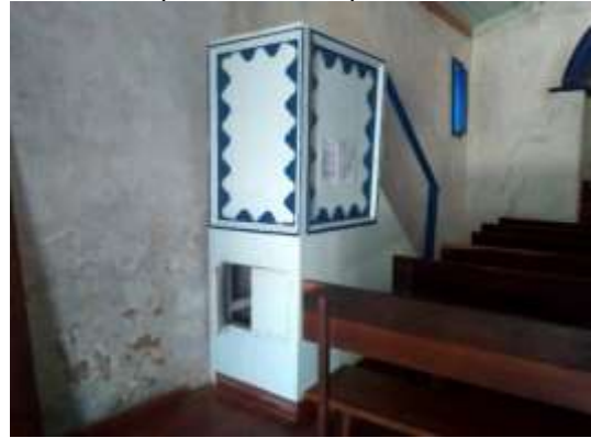
Figura 8: Foto do confessionário e detalhe da tinta se desprendendo da parede
