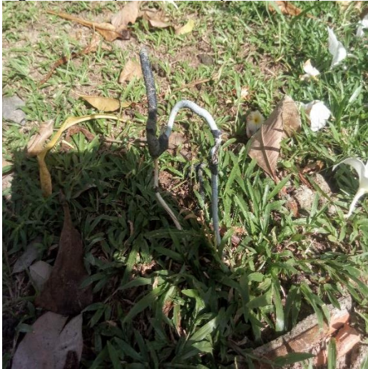
Figura 15: Fiação elétrica exposta na Praça
